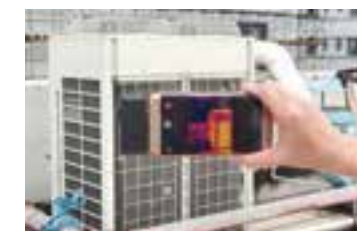
Проверка систем вентиляции
